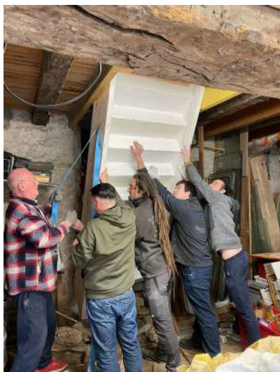
Illustration 33: Pose de l'escalier
