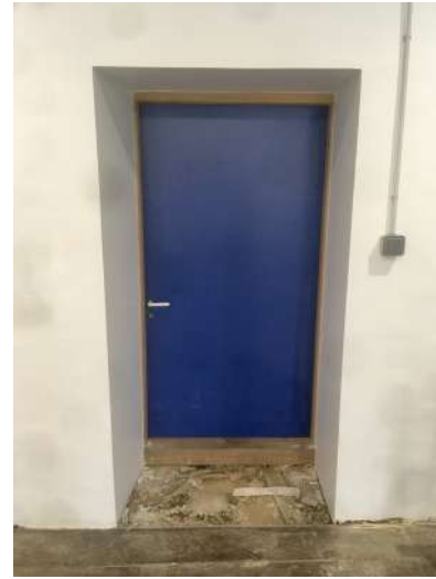
Illustration 31: Porte posée permettant le passage vers espace informatique
