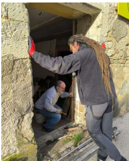
Illustration 28: Pose d'une nouvelle porte extérieure
