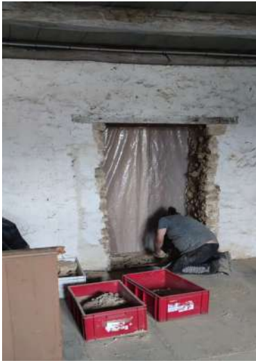
Illustration 30: ouverture d'une porte dans les futurs bureaux
