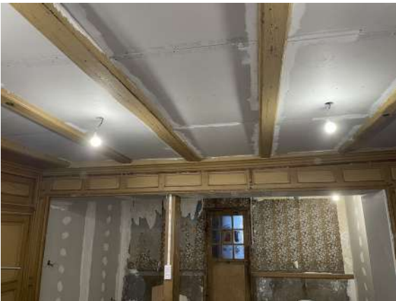
Illustration 32: Grande salle en cours de travaux
